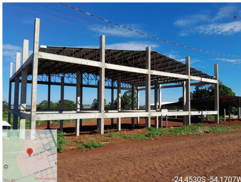
Foto 01: Visão noroeste da edificação do depósito.
