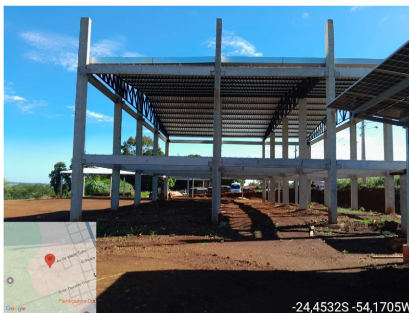
Foto 02: Visão lateral leste da edificação do depósito.
