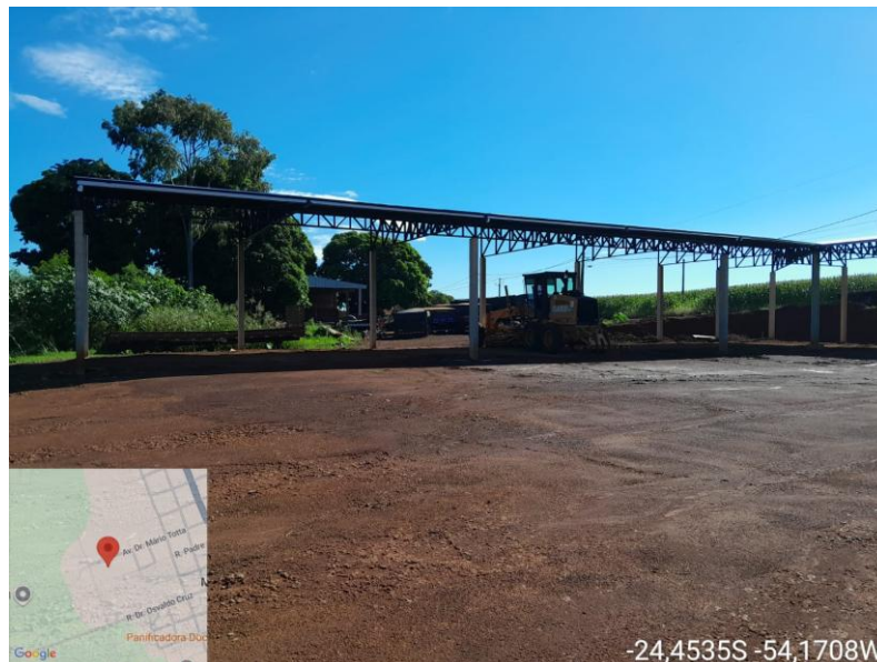
Foto 03: Visão lateral oeste da garagem.
